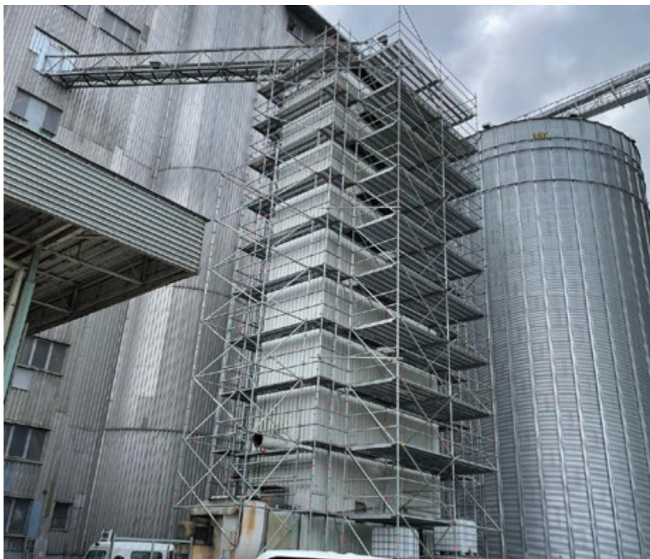
PRO-DOMA, SE – Oprava sušárny obilovin ZS Dynín
